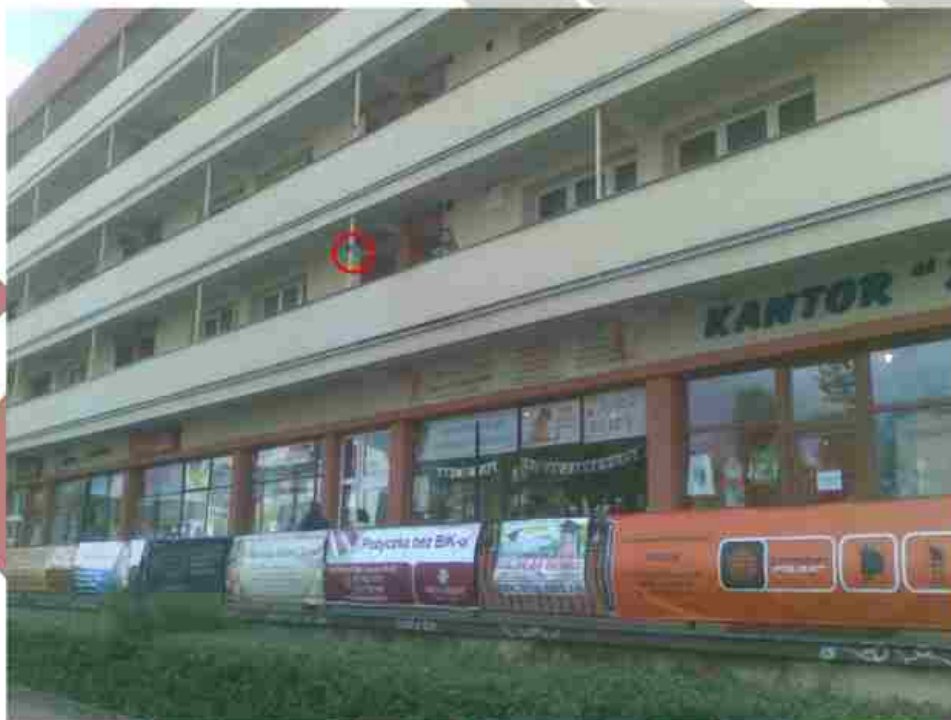
Rys. 2 Widok punktu pomiarowego na wysokości 1 piętra
